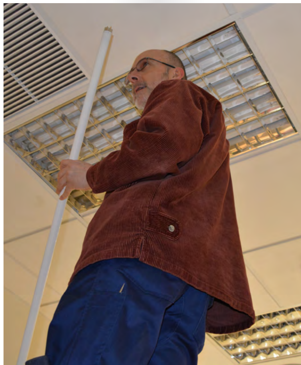
Uno de los profesionales de la Unidad Técnica cambiando un fluorescente
