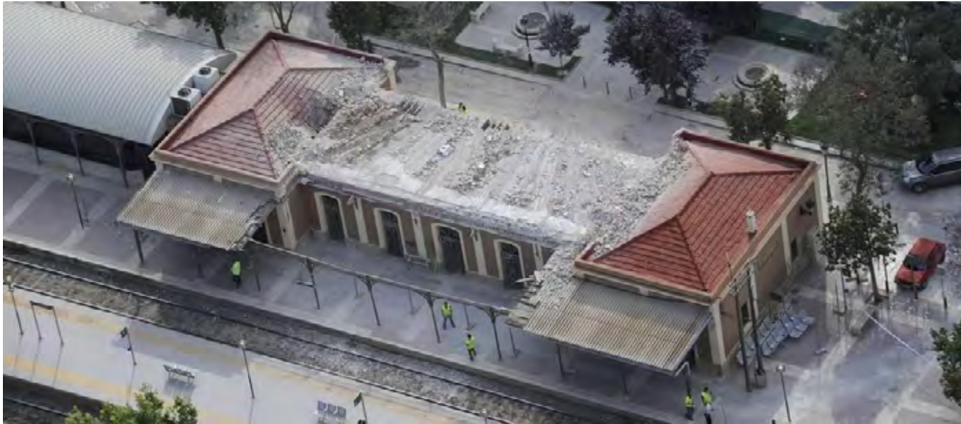
Estado en el que quedó la estación de Renfe en Lorca tras los terremotos de mayo de 2011.
